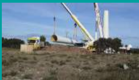
Démantèlement du premier parc éolien français à Port-la-Nouvelle en 2019. 96% des composants ont été recyclés.
